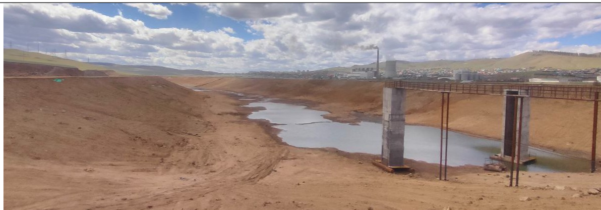
Шинээр барьж буй үнсэн сан
